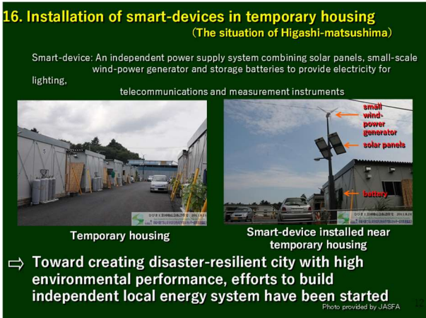
図1 仮設住宅の自立電源照明システム
